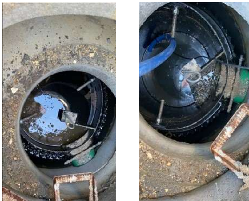
Bild 4-6: Hydraulische Prüfung (links); Absaugen des Schachtes (rechts)
