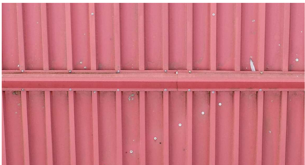
Abbildung 3.7: Südliche Dachfläche Ostendstr.2, Detail: Beschichtung intakt
