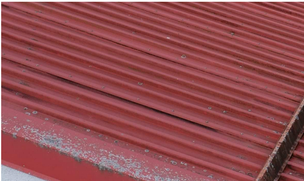
Abbildung 3.4: Nörtl. Dach Ostendstr. 2, Detail: Farb-Beschichtung intakt, Flechten, Schmutz
