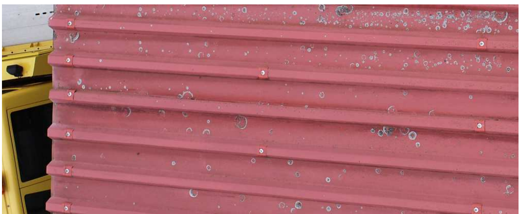
Abbildung 5.6: Östliche Dachfläche Ostendstr.4, Detail: Beschichtung intakt
