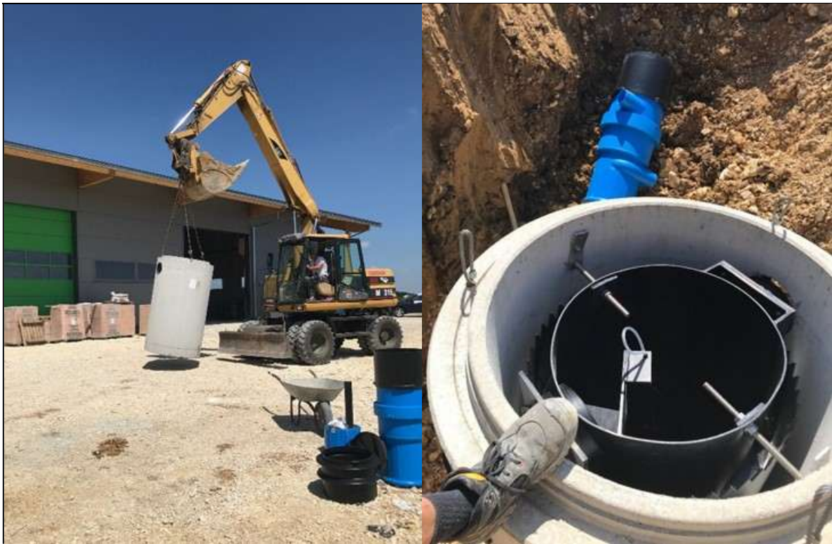
Bild 4-1: Einbau des Hydrosharks DN 1000
