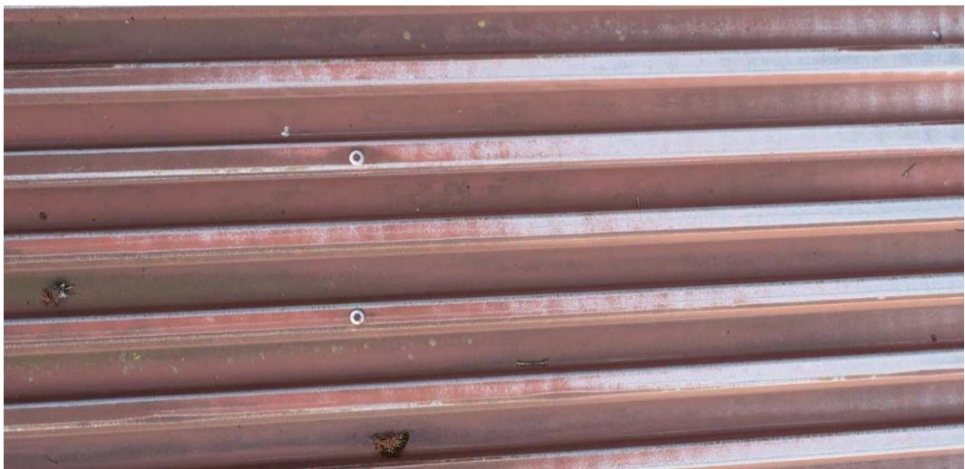
Abbildung 2.3: Nördlicher Anbau Ostendstr.1, Detail: Farb-Beschichtung löst sich
