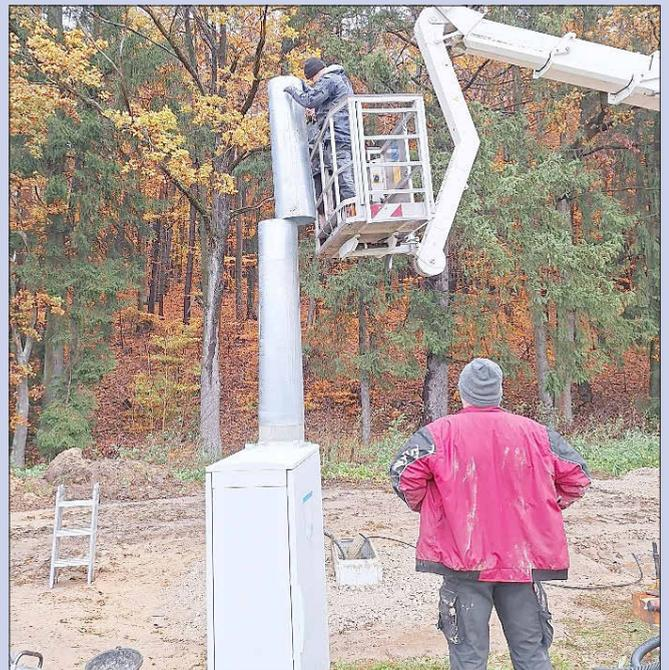
*Aufbau der einzelnen Maststücke mit Hilfe einer Hebebühne*
