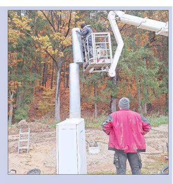
Aufbau der einzelnen Maststücke mit Hilfe einer Hebebühne
